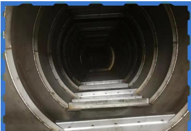
储料箱塔内部
